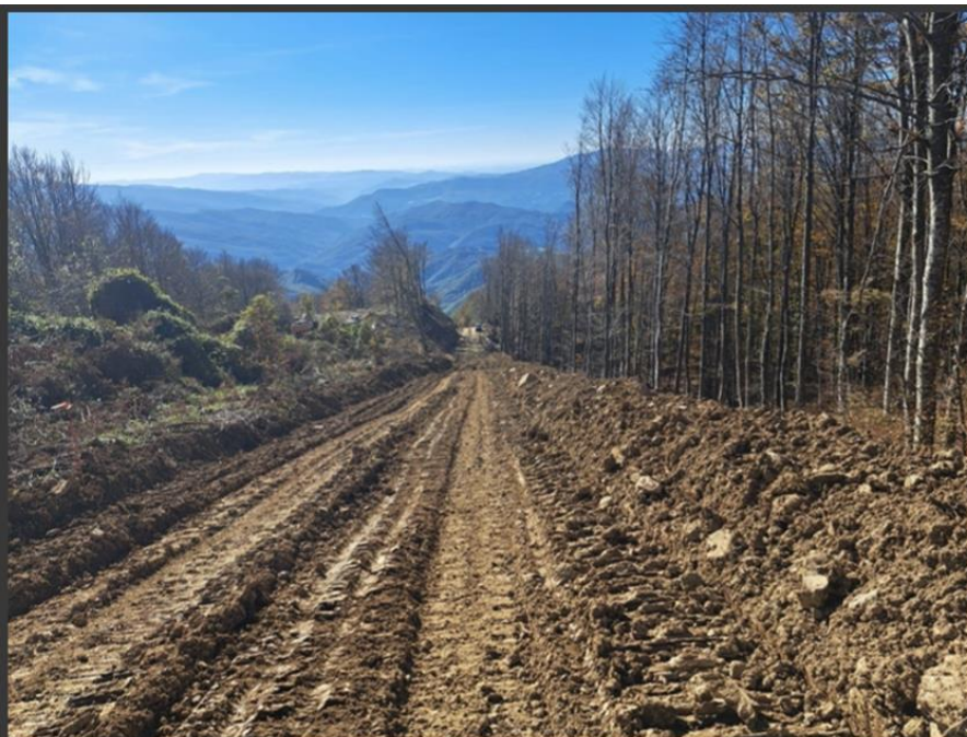
Monte Giogo di Villore, area cantiere
